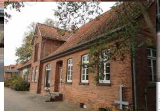
Vor der Sanierung kein wirklich schöner Anblick
