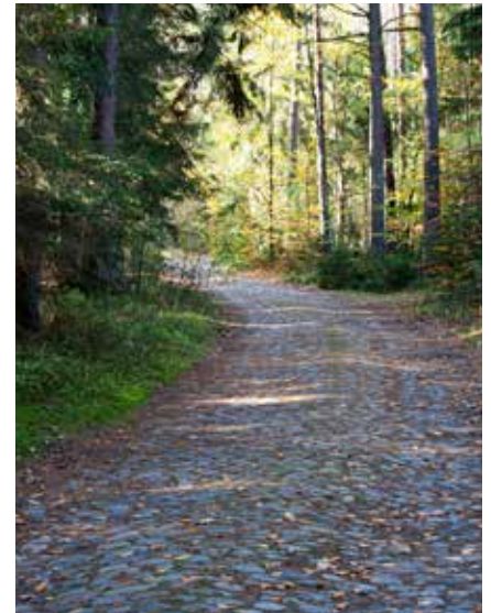
Auf der alten Zufahrtsstraße durch den Hainholz lohnt es andächtig zu fahren: die Straße hat extreme Spurrillen, aber die Pflastersteine sind noch original und kamen damals eigens aus England.
