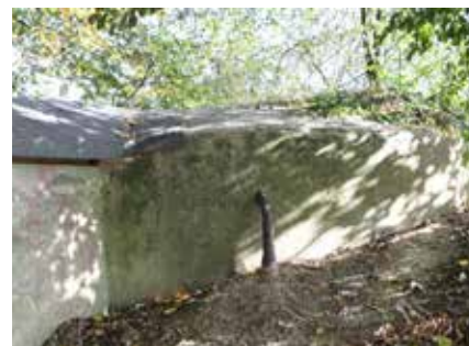
In dem Waldstück neben der Köhlerhütte steht der ehemalige "Wasserturm" von Gödenstorf. Man sieht noch die Zuleitung von der Widder-Anlage (Fotomitte).
